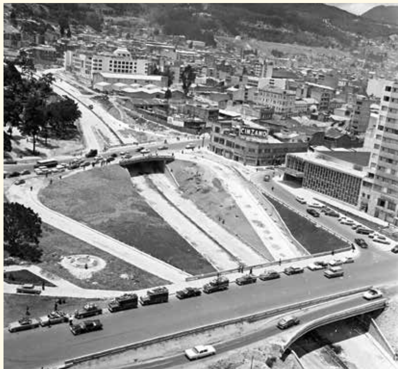
Trabajos de construcción de la avenida 26 entre las carreras 7.ª y 10.ª, sobre el espacio que anteriormente ocupó el Parque del Centenario 1962. Colección Manuel H., registro MdB11805, Museo de Bogotá
